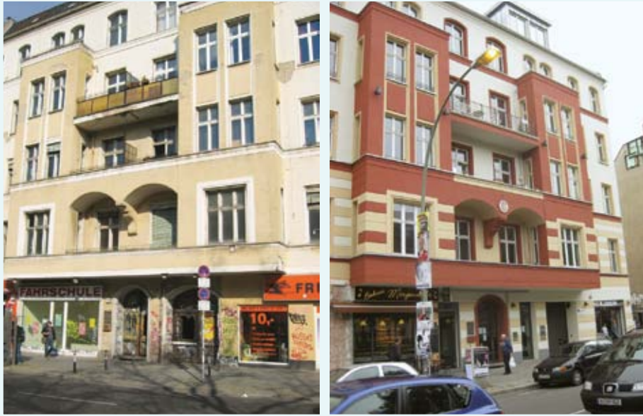
Warschauer Straße 60: Vorderhaus vor und nach der Sanierung
